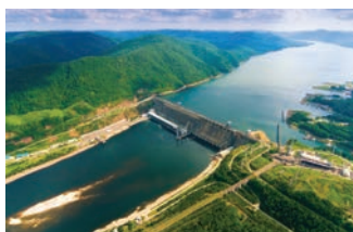
Красноярская ГЭС, г. Дивногорск
