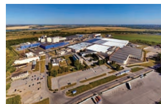
Завод «Проктер энд Гэмбл», г. Новомосковск
